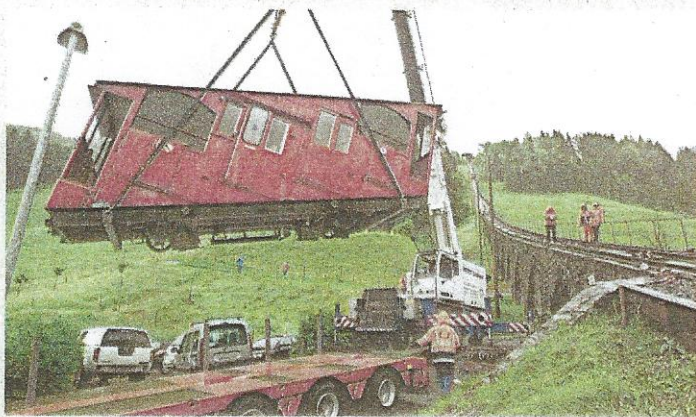
Les deux cabines de 7,3 tonnes seront démontées à Chernex.
